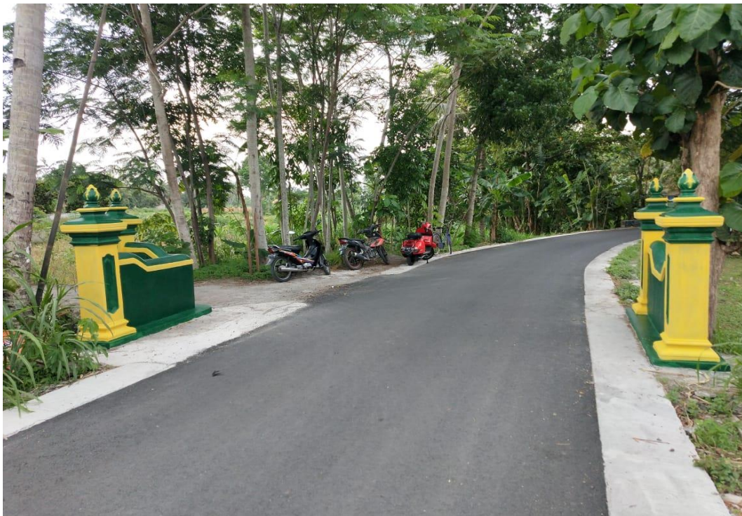
Gambar III.5 Perbaikan jalan Kabupaten di Desa Karangtalun
