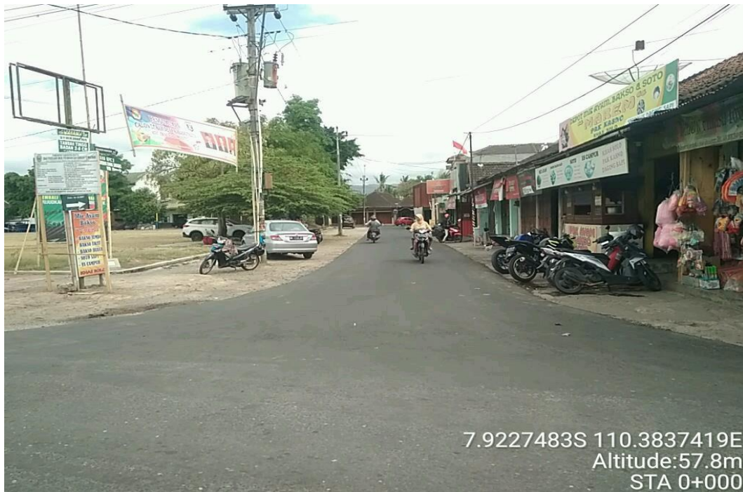
Gambar III.4 Perbaikan jalan Kabupaten di Desa Karangtalun
