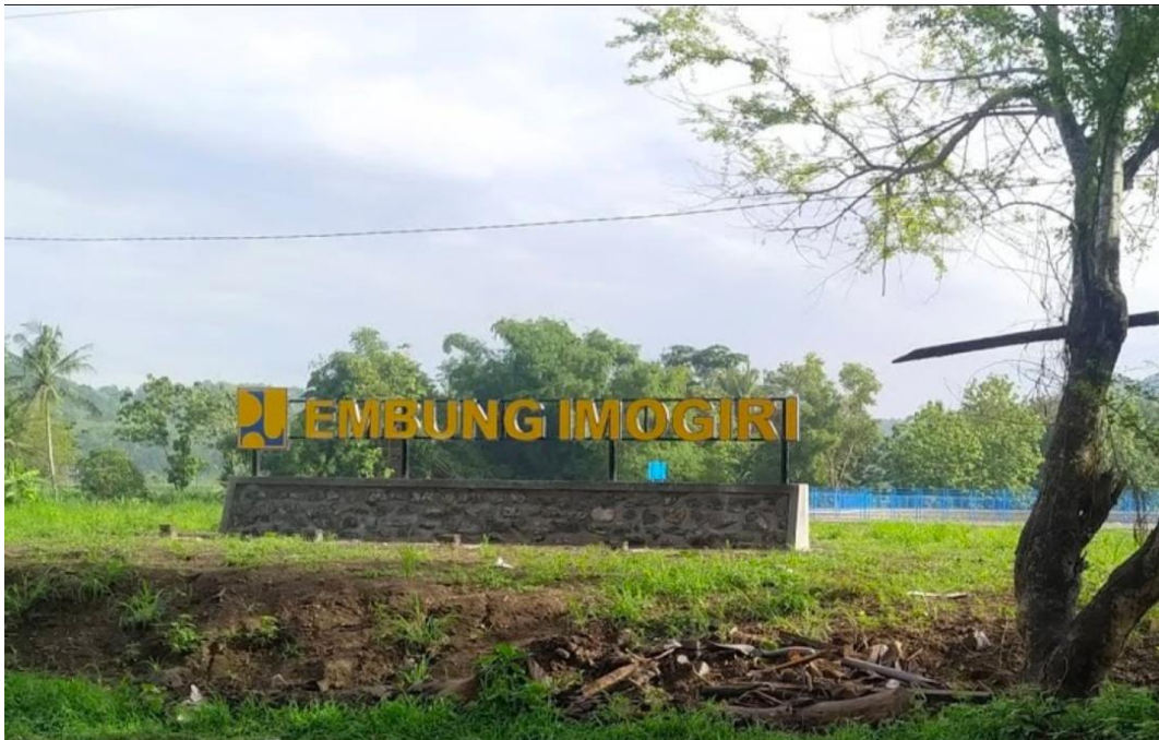
Gambar III.6 Pembangunan Embung Imogiri di Desa Girirejo
